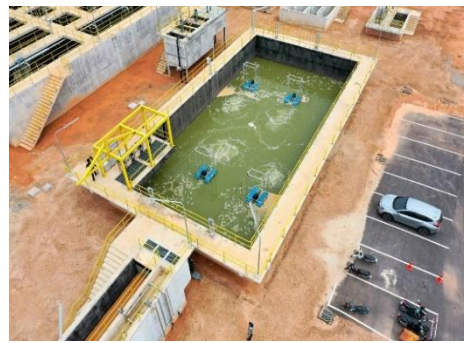
รูปที่ 2 ระบบบำบัดน้ำเสียส่วนกลางทางชีวภาพแบบตะกอนเร่ง (Activated Sludge)
