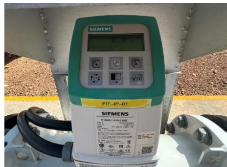
รูปที่ 3 เครื่องมือวัดอัตราการไหลของน้ำเสียก่อน-หลังออกจากระบบบำบัดน้ำเสียส่วนกลาง
